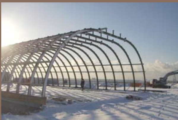
Könnyű, mégis szilárd. Az egyes szerkezeti elemeket akár két ember is könnyedén összeszereli, mint egy hatalmas építőjátékot.
